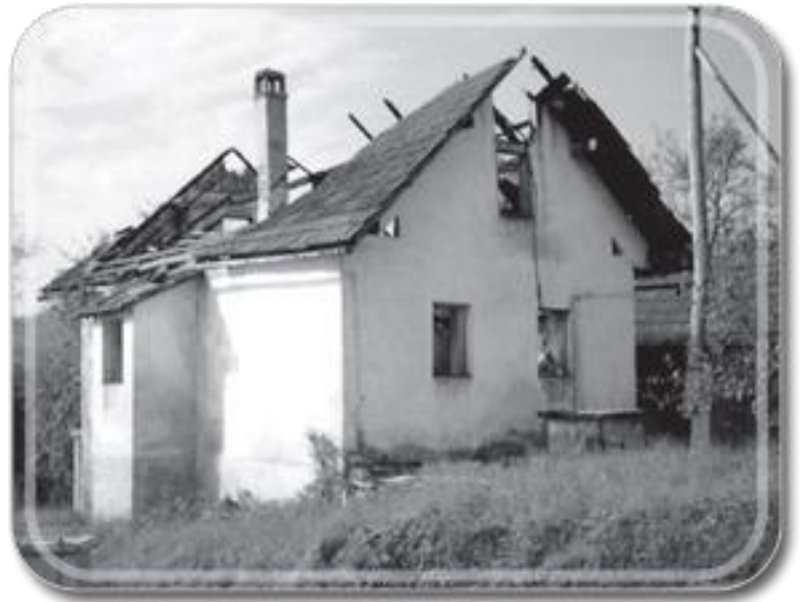
Ostanki požara na Selih 1998
